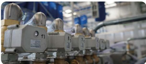
Electroválvulas 1" de depósitos a lavadoras y de las bombas a los depósitos
